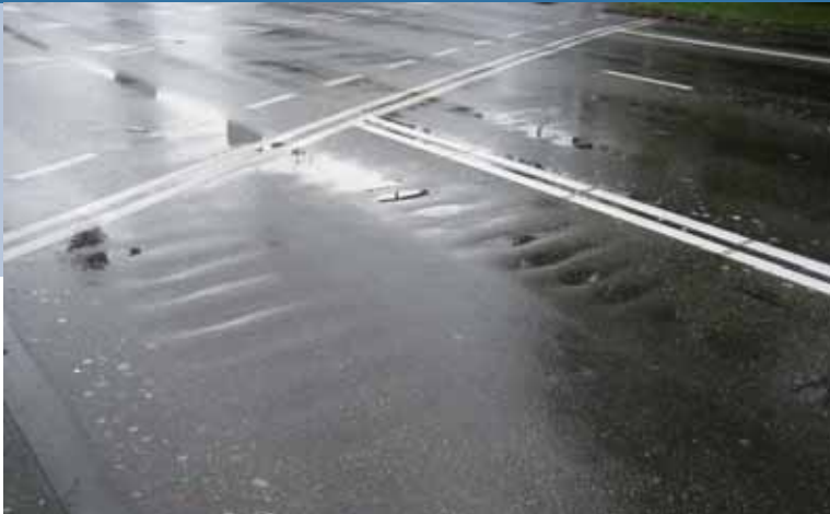
Gelijktijdig aangebrachte opstelplaatsen zes jaar na aanleg. (Links: DAB 0/11, VK 4, bitumen 40/60. Rechts: MODUS met bitumen 70/100)
