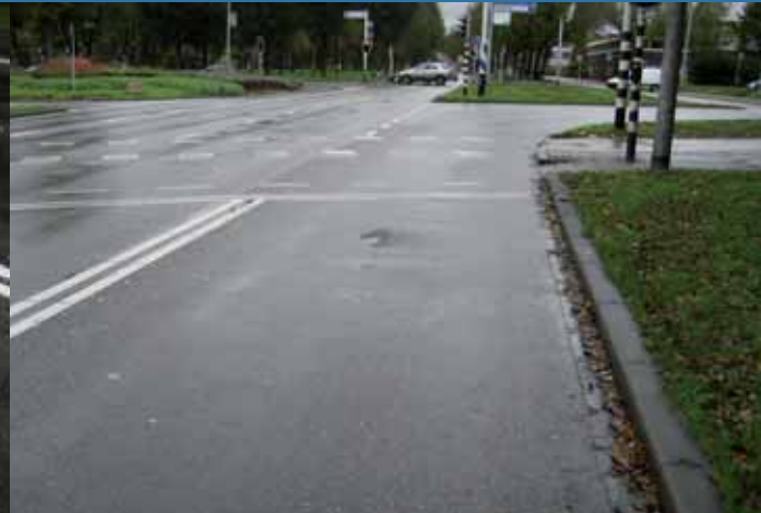
Gelijktijdig aangebrachte opstelplaatsen zes jaar na aanleg. (Links: DAB 0/11, VK 4, bitumen 40/60. Rechts: MODUS met bitumen 70/100)
