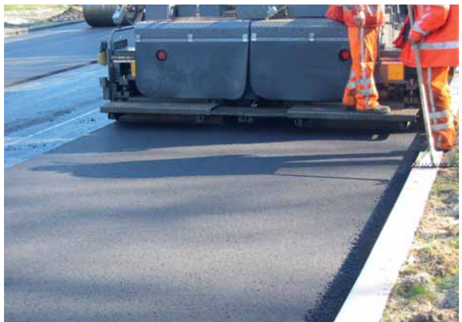
Uitvoeren proefvak (MODUS) op Einsteindreef in april 2003 (linksboven is het gelijktijdig aangebrachte referentievak zichtbaar).
