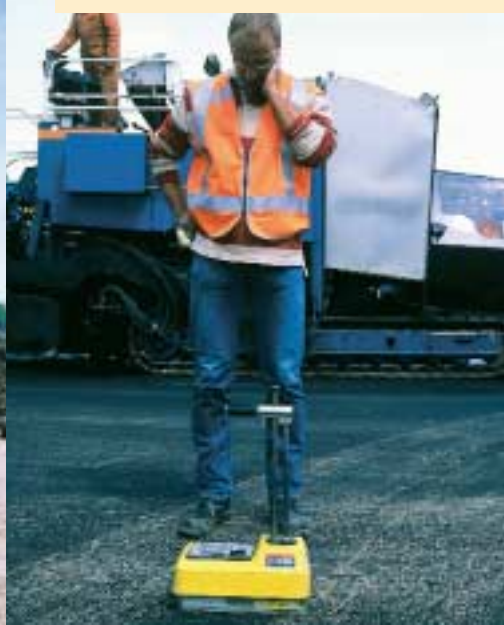
Bepaling dichtheid van het asfalt tijdens de uitvoering
